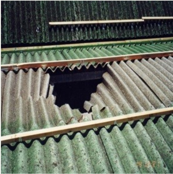
Sfondamento copertura
