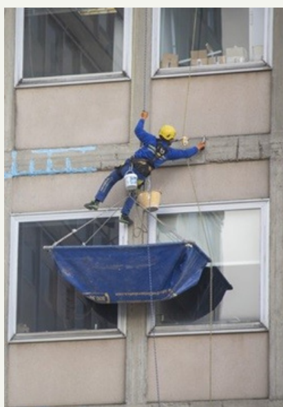
Operatore posizionato su fune mentre esegue il lavoro
